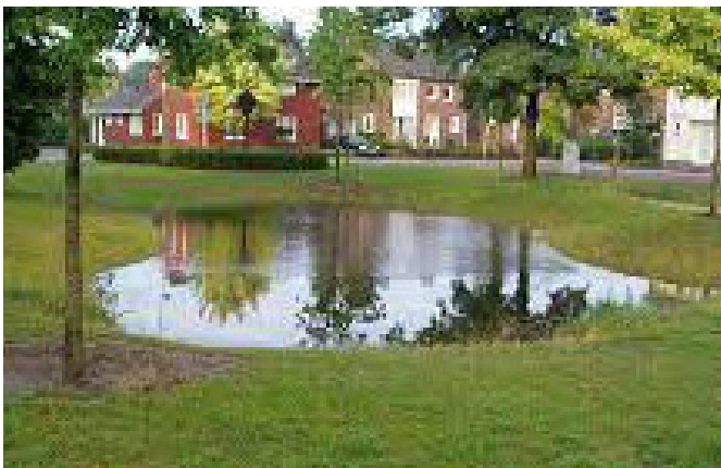
Temporary ponding in wadi
